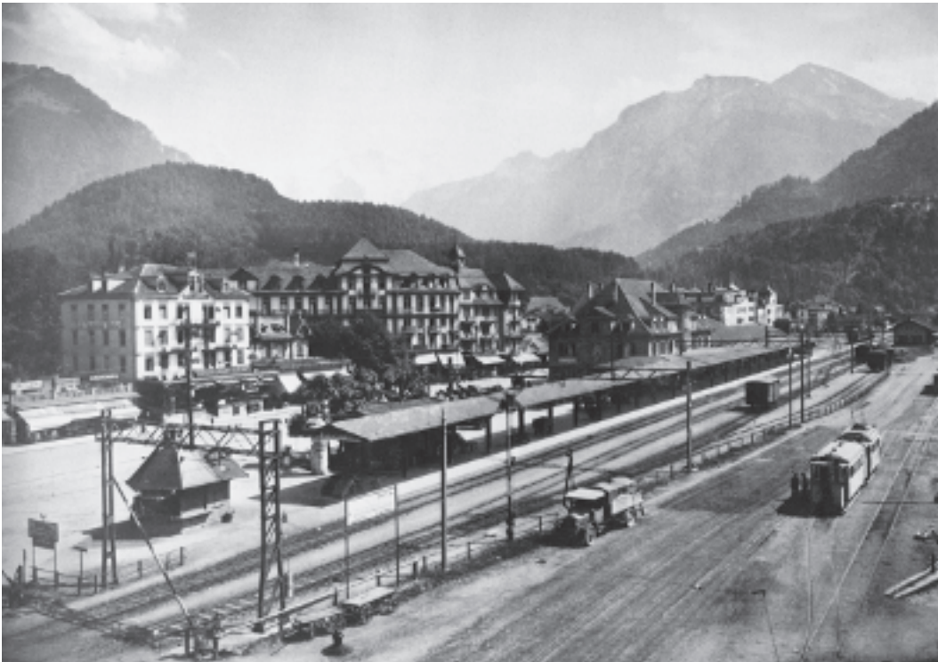
Abb. 78 – Die STI-Endstation beim Bahnhof Interlaken-West
