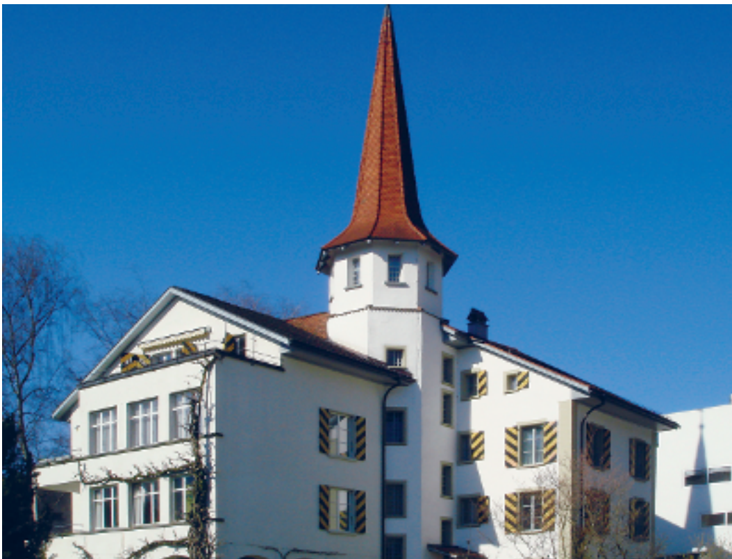
Abb. 122 – Das Schloss Unterseen, Kirchgemeindehaus seit 1967, mit Pfarrwohnung, Gemeinschafts- und Arbeitsräumen
