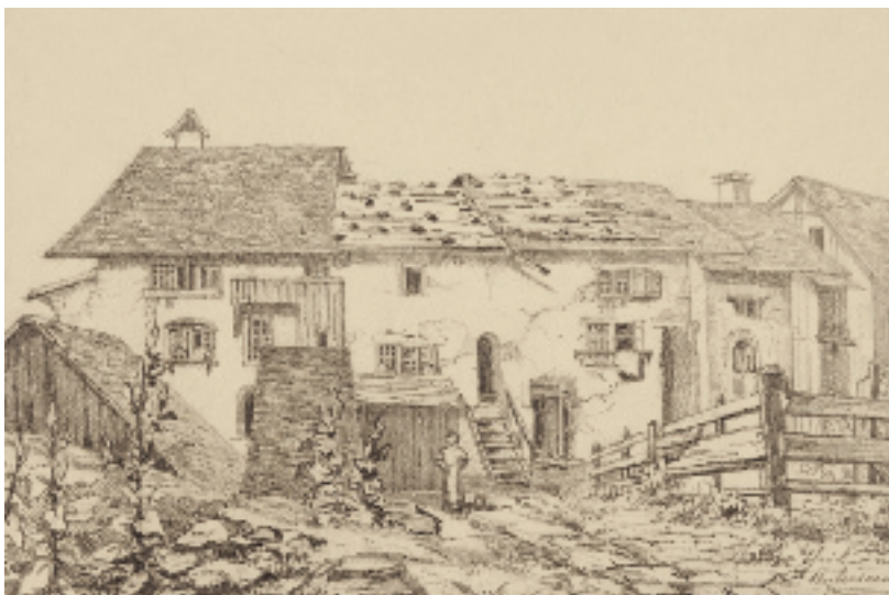
Abb. 16 – Häuserzeile der Oberen Gasse, Ansicht von der Graben- seite her
