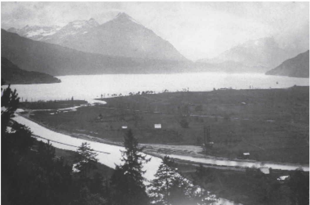
Abb. 72 – Umleitung der alten Aare in den Kanal und das neue Aarebett.
