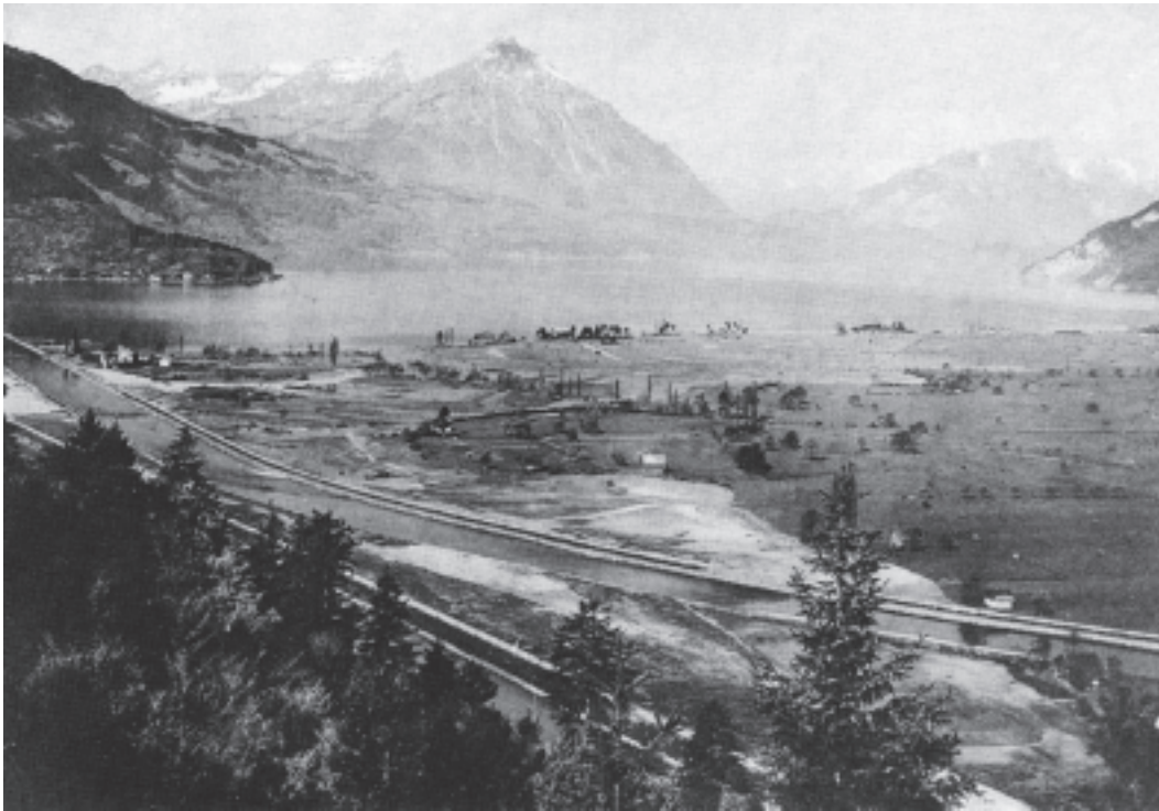
Abb. 73 – Kanalbau und Eindämmung der Aare
